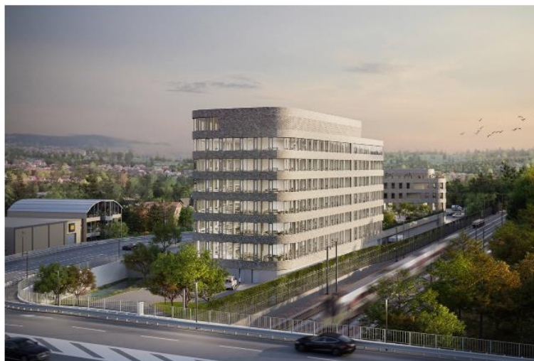
Le projet est développé sur l'ancien site de l'usine à cigarettes Heintz van Landewyck. (Illustration: BFF...)
